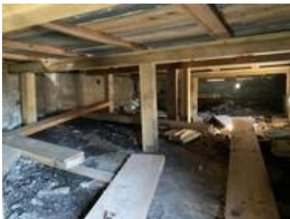
Krypkjeller mot sør.
