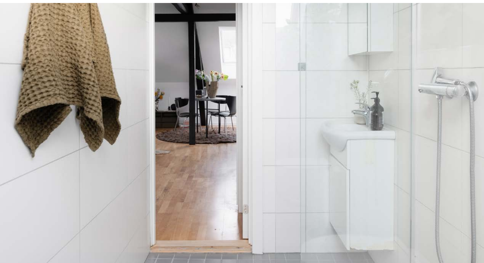
Varmekabler i baderomsgulv. Servantinnredning med skap og vegghest speilskap.
