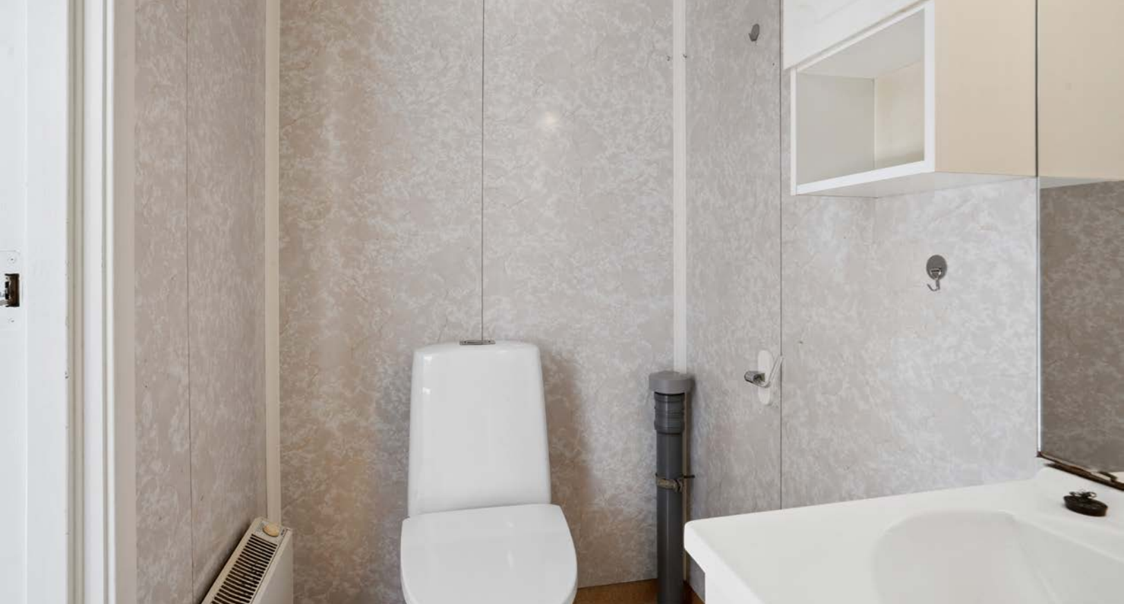
Boligen har et eldre bad med våtromsplater på vegger og vinylbelegg på gulv.
