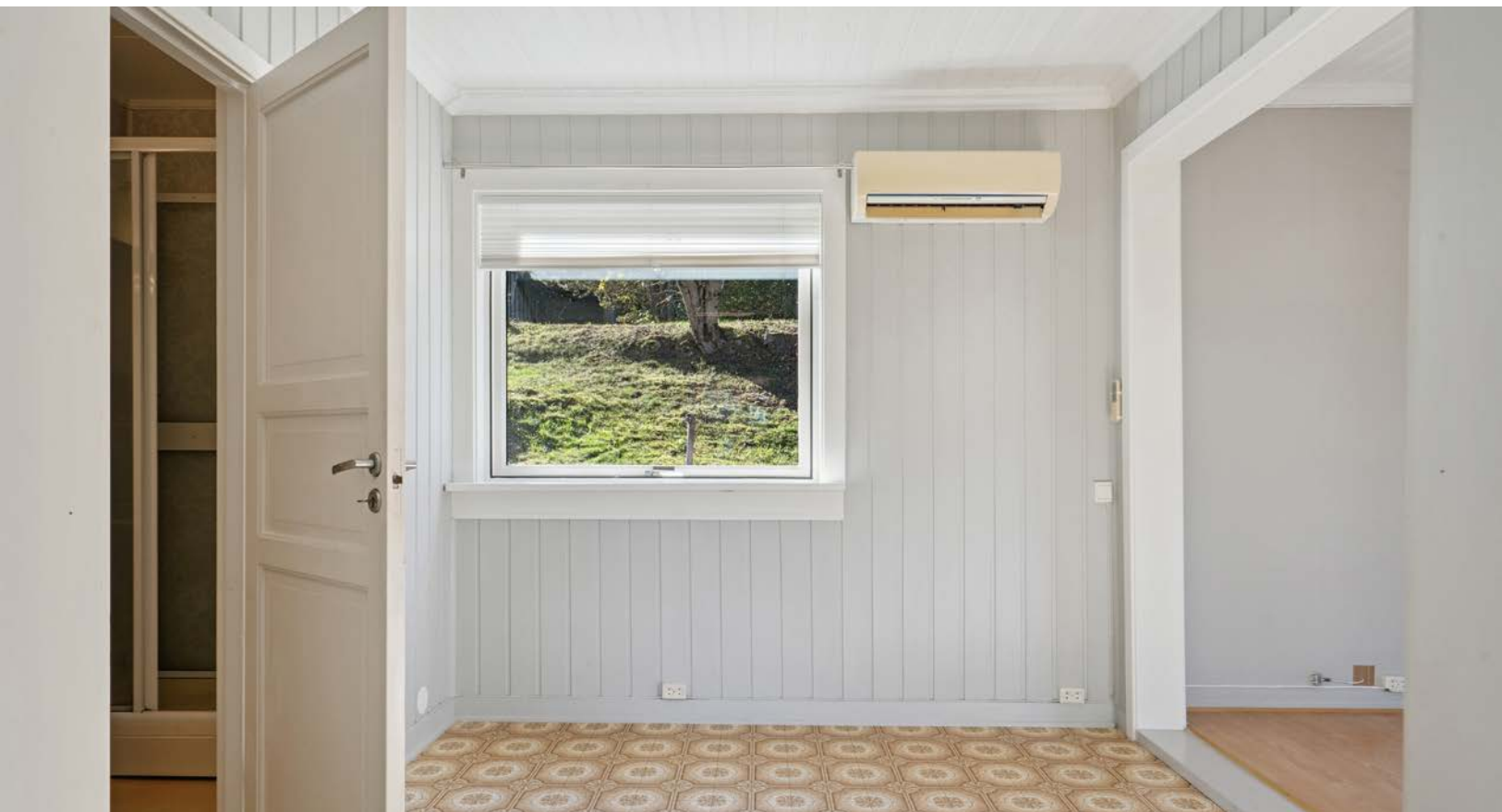
Det er også en varmepumpe.
