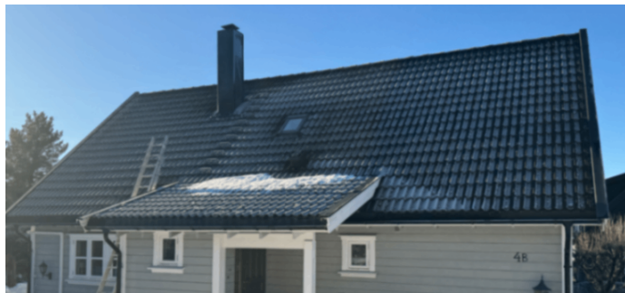
Takstein besiktiget fra bakkenivå
