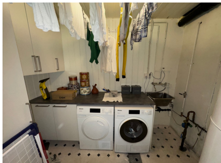
Eldre vaskerom med hovedkonstruksjon fra byggeår
