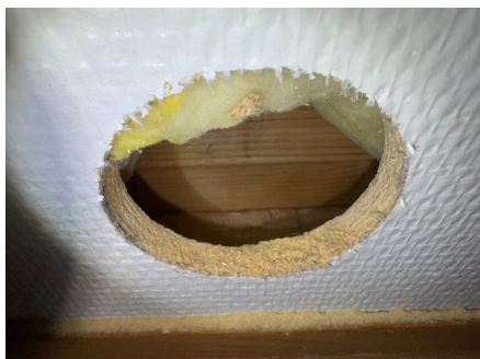
Hulltaking i tilstøtende soverom
