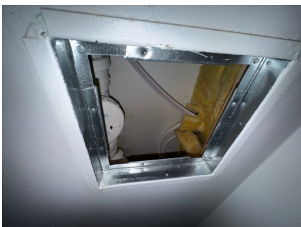
Inspeksjonsluke til stakepunkt i toalettrom
