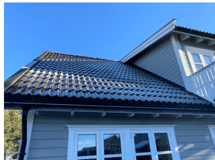
Takstein besiktiget fra bakkenivå
