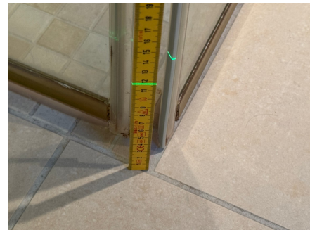
Fallforhold ca. 117 mm overkant gulv ved dusjsone
