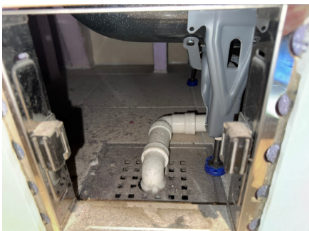
Plastsluk med klemring under badekar
