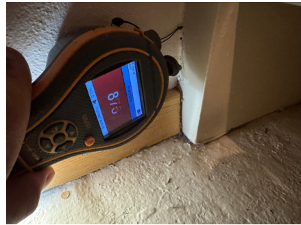
Overflatesøk med fuktindikator på nedkant grunnmur/kjellervegg
