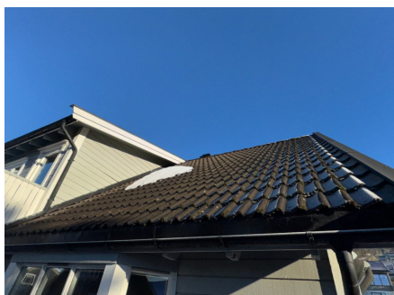
Takstein besiktiget fra bakkenivå
