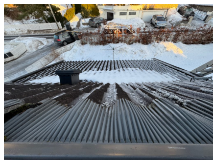
Takstein besiktiget fra takvindu
