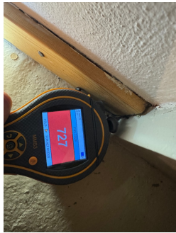
Overflatesøk med fuktindikator kjellergulv
