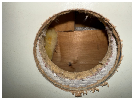
Hulltaking i tilstøtende gang
