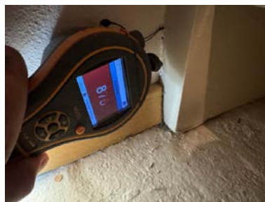
Overflatesøk med fuktindikator på nedkant grunnmur/kjellervegg
