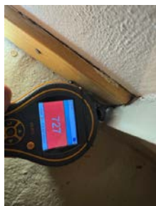
Overflatesøk med fuktindikator kjellergulv
