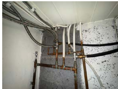
Vannrør i kobber og kobber med plastkappe
