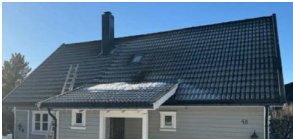
Takstein besiktiget fra bakkenivå
