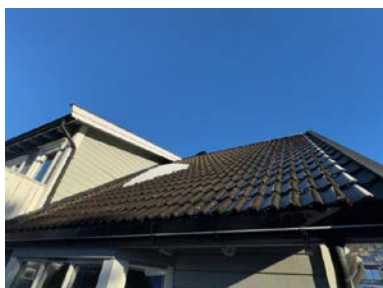
Takstein besiktiget fra bakkenivå
