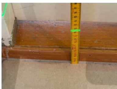
Fallforhold ca. 115 mm overkant gulv ved terskel
