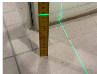
Fallforhold ca. 116 mm overkant gulv ved dusjsone
