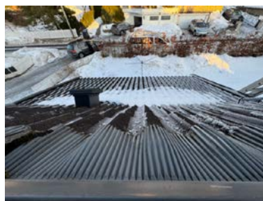
Takstein besiktiget fra takvindu
