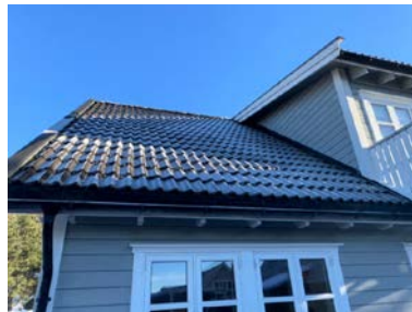
Takstein besiktiget fra bakkenivå
