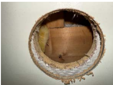
Hulltaking i tilstøtende gang
