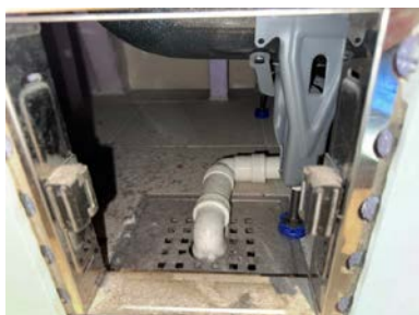
Plastsluk med klemring under badekar
