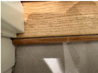
Membran oppbrett ved terskel
