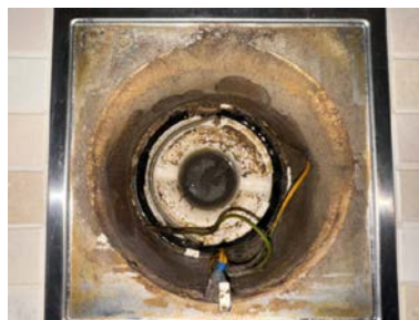
Plastsluk med klemring og synlig membran i dusjsone
