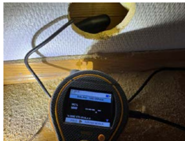
Hulltaking i tilstøtende soverom
