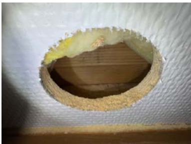
Hulltaking i tilstøtende soverom
