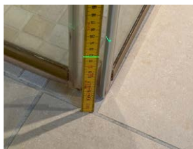
Fallforhold ca. 117 mm overkant gulv ved dusjsone
