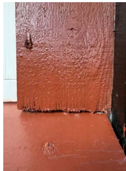
Belastning ned mot vannbrett bør ha ca 8mm dryppkant. Vannbrett bør utføres med beslag.
