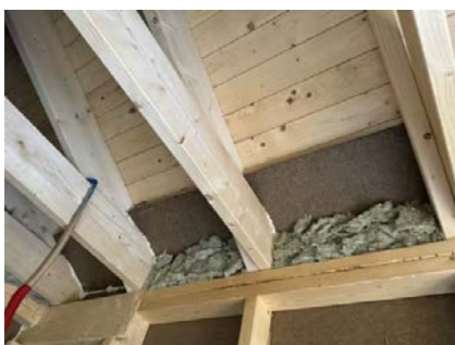
Bilde fra bod med utvendig tilkomst, det er etablert lufting i skråtak over yttervegg.
