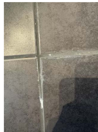
Stedvis noe mindre kalkutslag i flisfuger på gulv.
