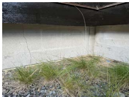
Drenerende masser rundt grunnmuren.
