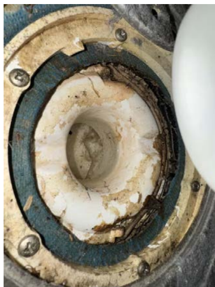
Membran er synlig i sluk.
