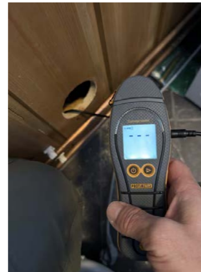
Det er ikke målt fukt i veggen.
