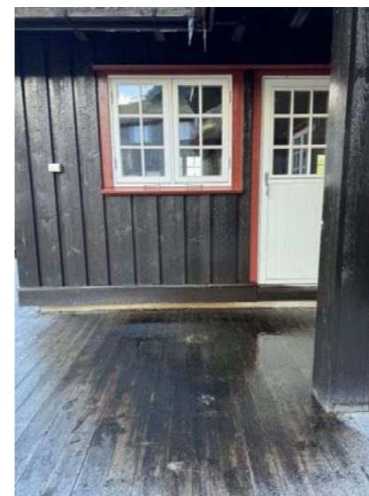
Lekkasje fra takrenner over inngangspartiet.
