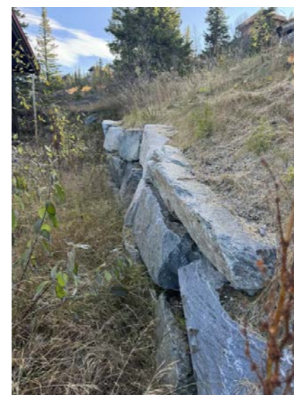
Støttemur i naturstein.
