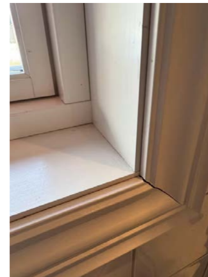
Vindu i våtsonen har ingen synlige skader.
