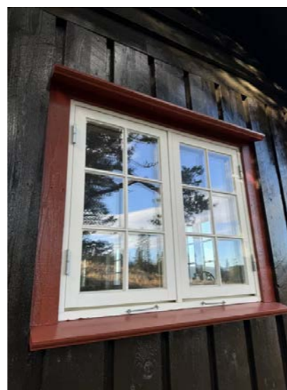
Belastning ned mot vannbrett bør ha ca 8mm dryppkant. Vannbrett bør utføres med beslag.
