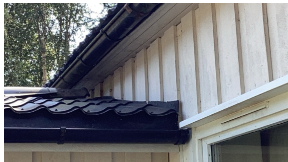
Overgang mellom tak og vegg over entre.
