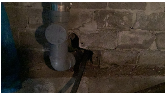
Stakepunkt i kjeller.
