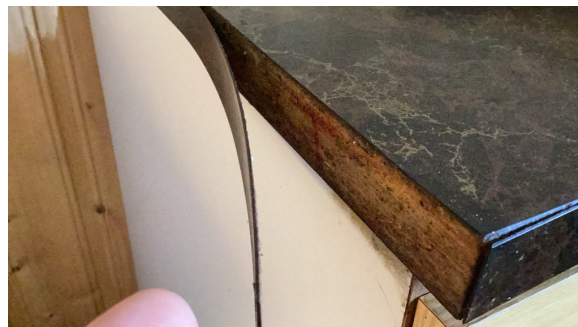
Eksempel på slitasje.
