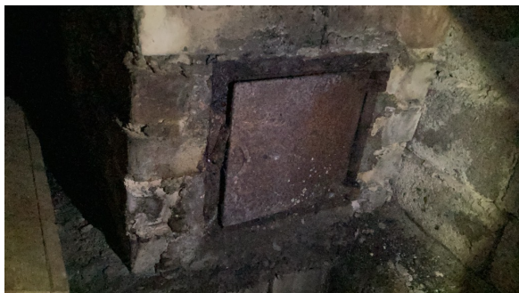
Sotluke i kjeller.
