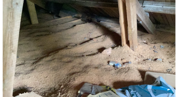
Oversiktsbilde fra loft
