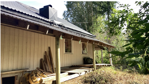
Skjermtak på bakside.
