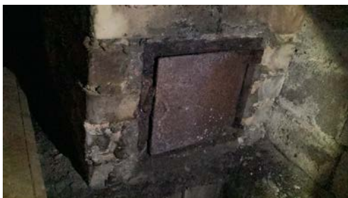
Sotluke i kjeller.
