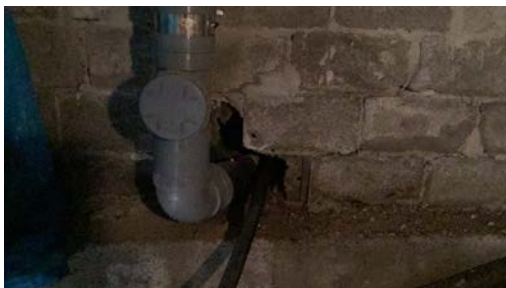
Stakepunkt i kjeller.
