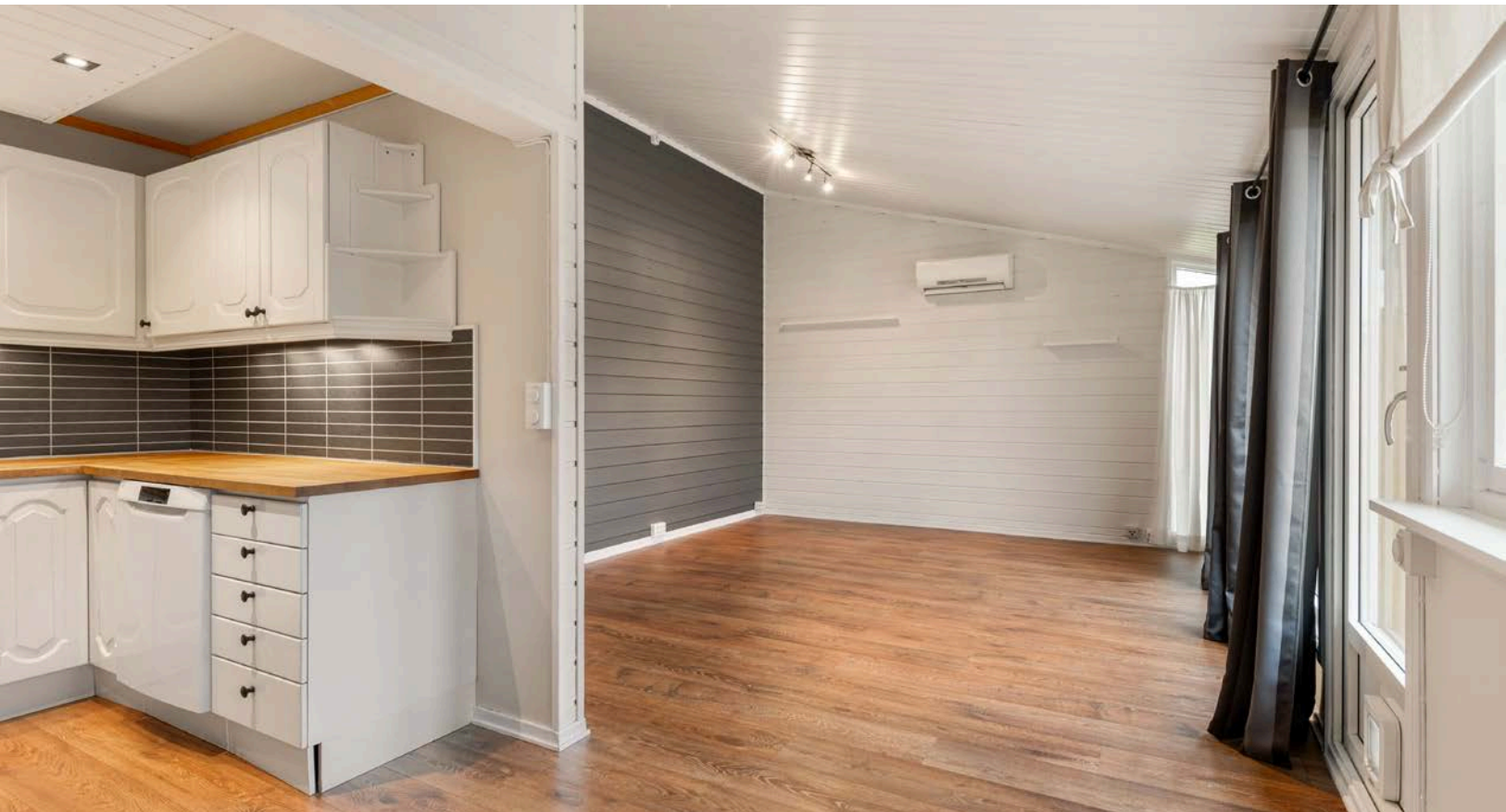
I stuen er det montert luft-til-luft varmepumpe fra 2009 som sørger for en god og jevn varme på vinterstid.
