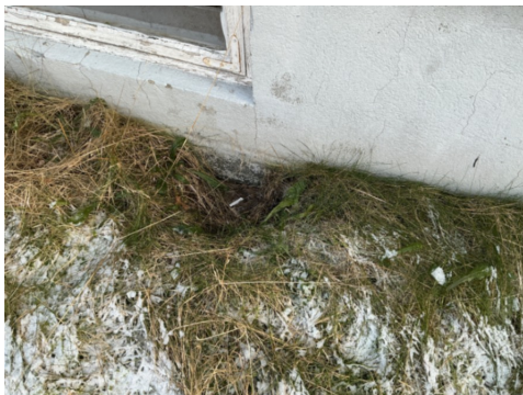
Drenering fra byggetid på det meste av kjellervegger
