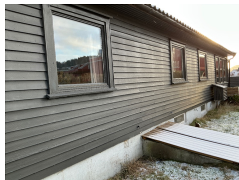
Eldre/original kledning på langvegg mot hage
