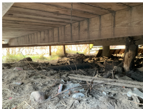
Stedvis langt spenn på bjelker uten understøtte
