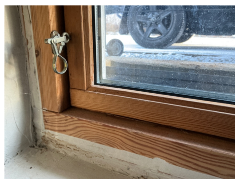
Vindu i tilbygg fra byggetid
