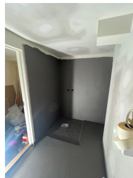
Bilde tilsendt fra smøring av membran
