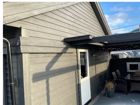
Skiftet kledning på gavlvegg i 2015
