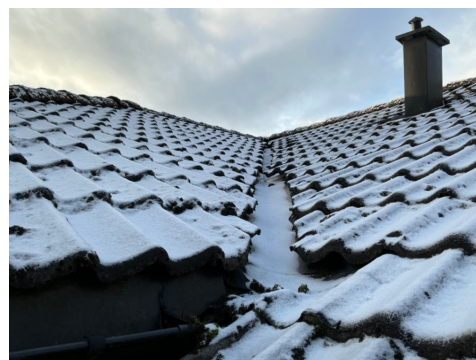
Uryddig tilpasning og legging av stein mot kilrenne
