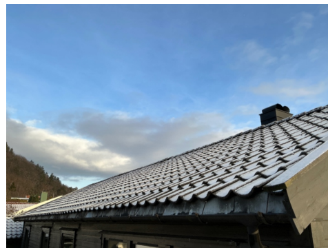
Takflate på hageside
