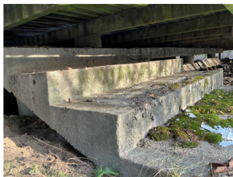
Man kan se at terrasse er delvis bygd over eldre del med støpt utførelse
