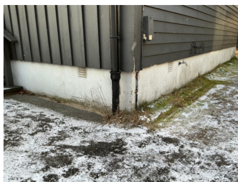
Lufteventiler i grunnmur som indikerer blindkjeller
