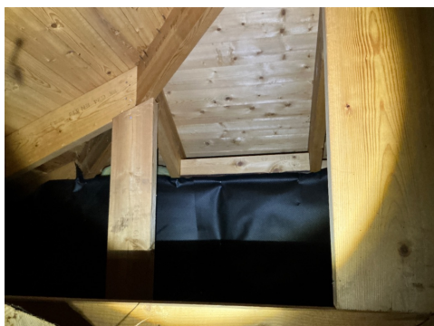
Tilbygd del med begrenset tilgang
