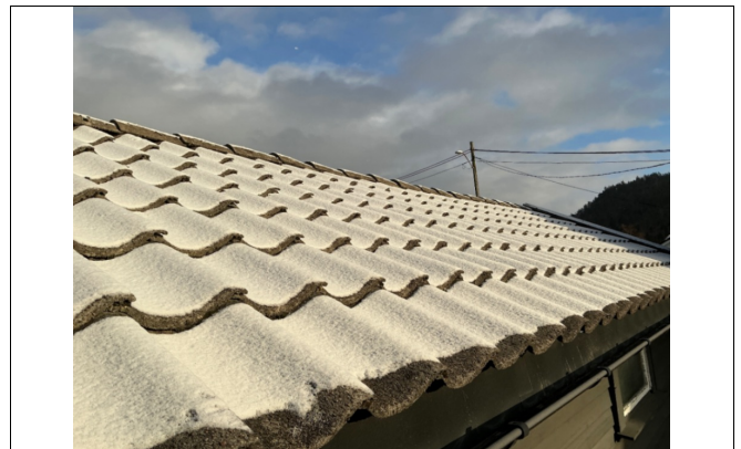
Takflater snødekt ved befaringen
