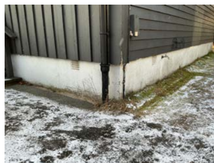
Lufteventiler i grunnmur som indikerer blindkjeller
