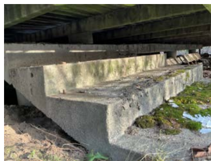
Man kan se at terrasse er delvis bygd over eldre del med støpt utførelse
