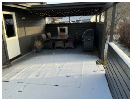
Snødekte flater på terrasse ved befaringen
