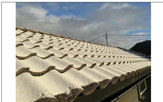
Takflater snødekt ved befaringen
