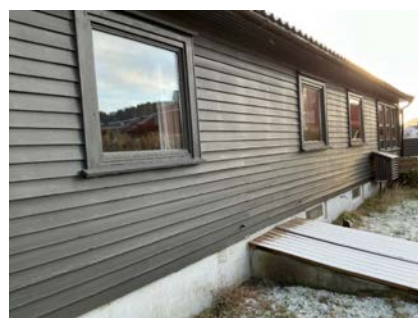
Eldre/original kledning på langvegg mot hage
