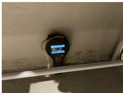
Ingen unormale utslag ved bruk av fuktindikator på murvegg (stikk kontroll)
