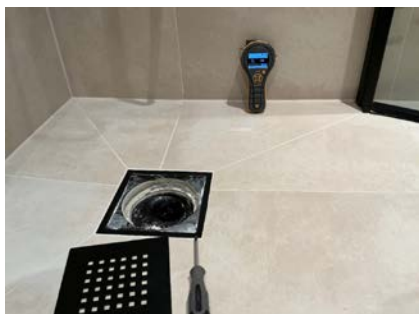
Ingen unormale utslag ved bruk av fuktindikator
