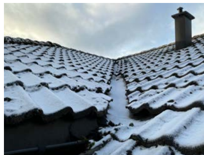
Uryddig tilpasning og legging av stein mot kilrenne
