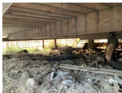
Stedvis langt spenn på bjelker uten understøtte
