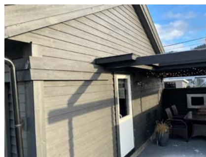
Skiftet kledning på gavlvegg i 2015
