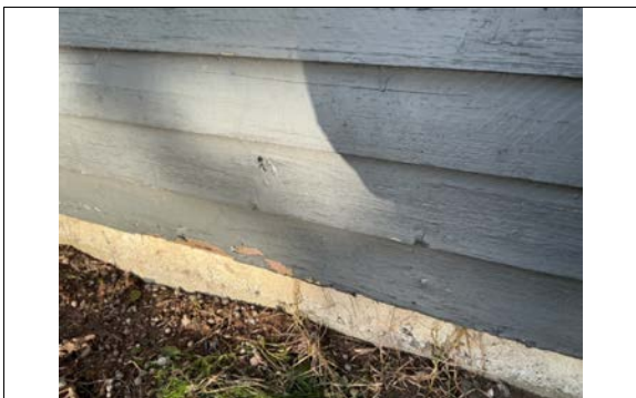
Sporadisk dårlige kledningsbord
