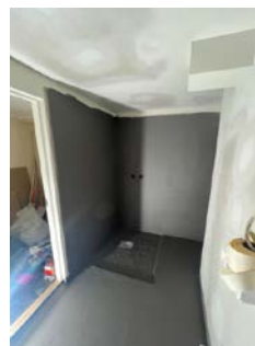
Bilde tilsendt fra smøring av membran
