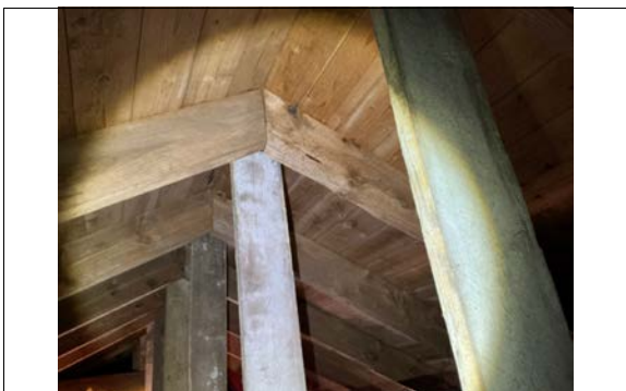
Undertak kun delvis synlig/tilgjengelig ved befaringen. Ingen synlige lekkasjer registrert
