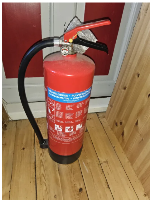
Bilde viser brannslukningsapparat.
