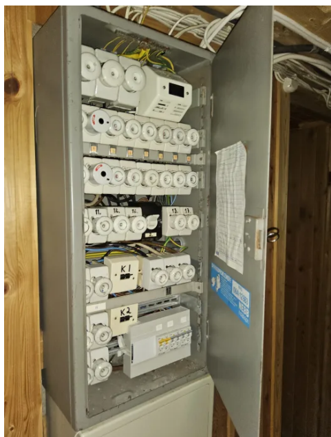
Bilde viser dårlig innfesting på kabler.
