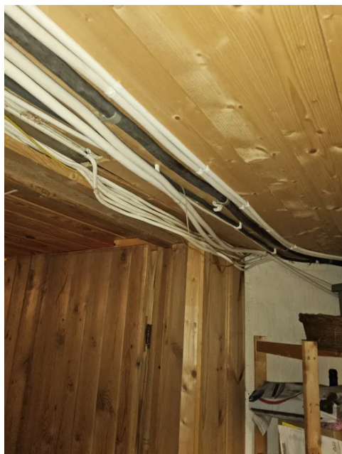
Bilde viser dårlig innfesting på kabler.
