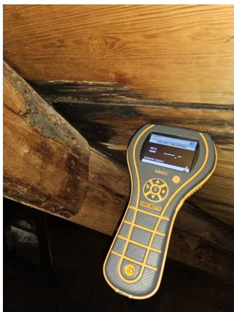
Bilde viser fuktmåling i taktro.
