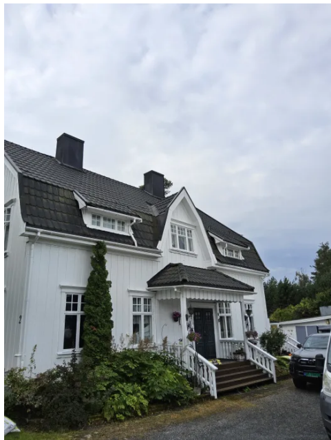
Bilde viser fasade mot nord.
