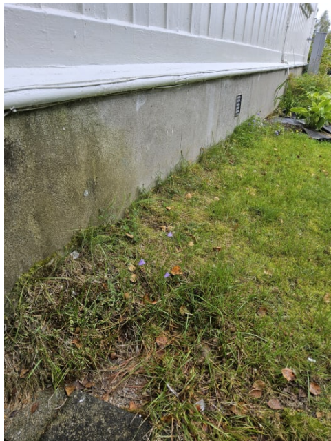
Bilde viser grunnmur.
