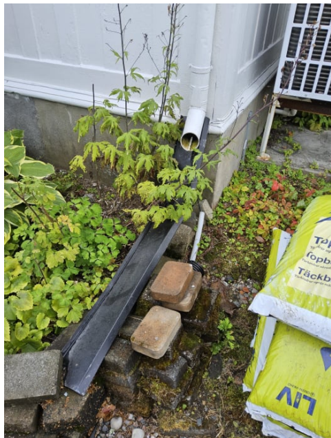
Bilde viser taknedløp avsluttet over bakken.
