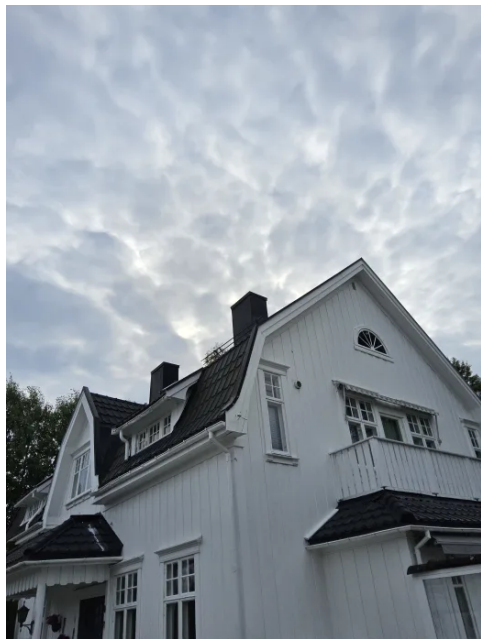
Bilde viser yttertak.
