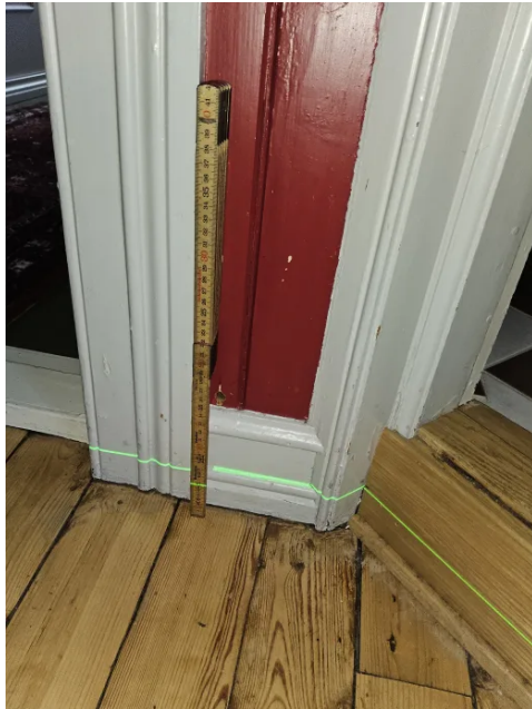
Bilde viser måling av etasjeskiller.
