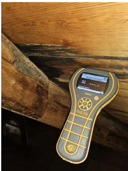
Bilde viser fuktmåling i taktro.
