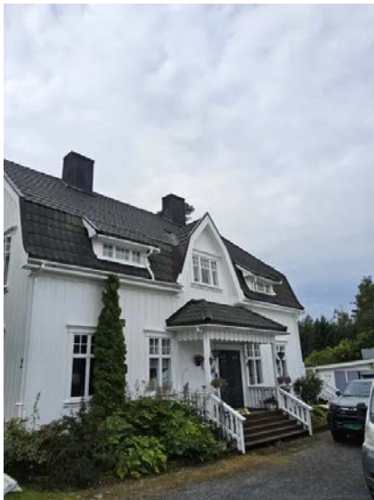
Bilde viser fasade mot nord.
