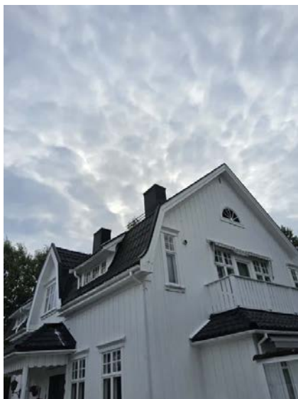
Bilde viser yttertak.
