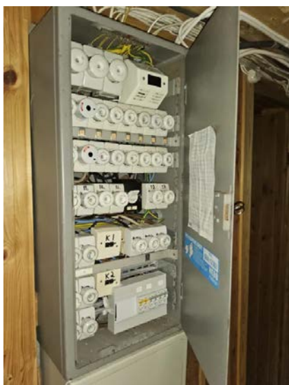
Bilde viser dårlig innfesting på kabler.
