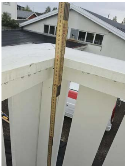
Bilde viser lavt rekkverkshøyden.
