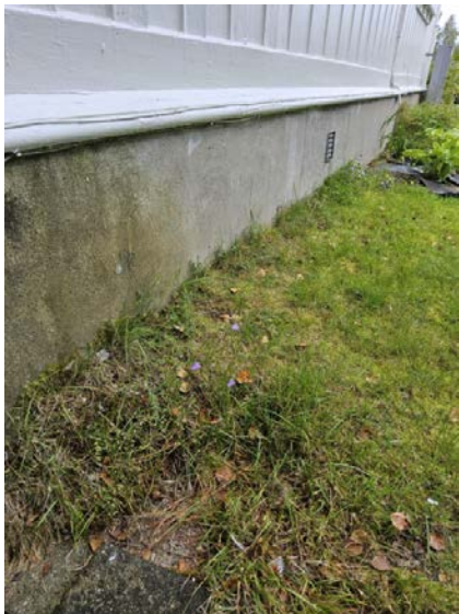
Bilde viser grunnmur.
