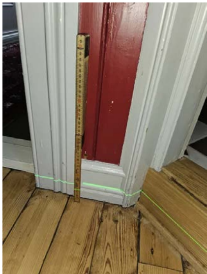
Bilde viser måling av etasjeskiller.
