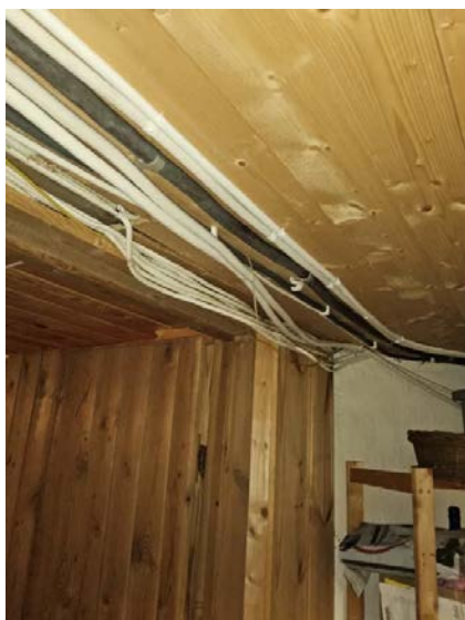
Bilde viser dårlig innfesting på kabler.
