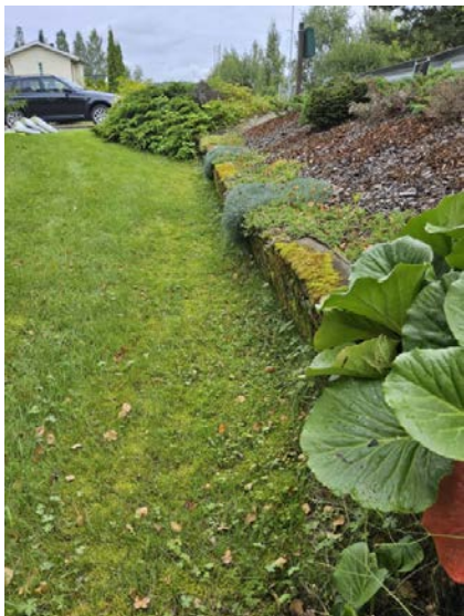
Bilde viser støttemur.
