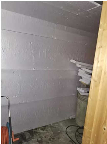
Bilde viser isopor på vegg/himlingsflater.
