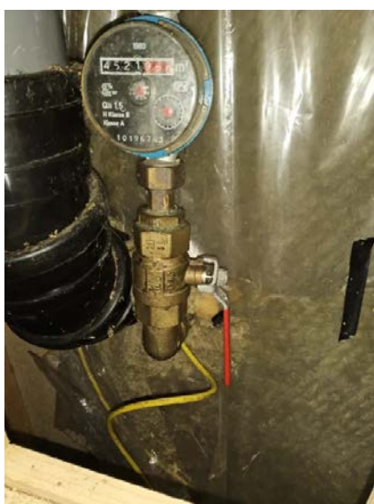
Bilde viser hovedstoppekran.
