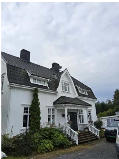
Bilde viser manglende bruk av snøfanger.
