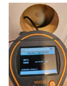
Måling av trefukt i veggkonstruksjon mellom soverom og dusjsone på bad.
