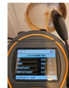
Måling av relativ luftfuktighet i veggkonstruksjon mellom soverom og dusjsone på bad.
