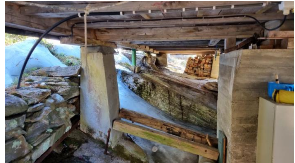
Kontroll av fundamenter.
