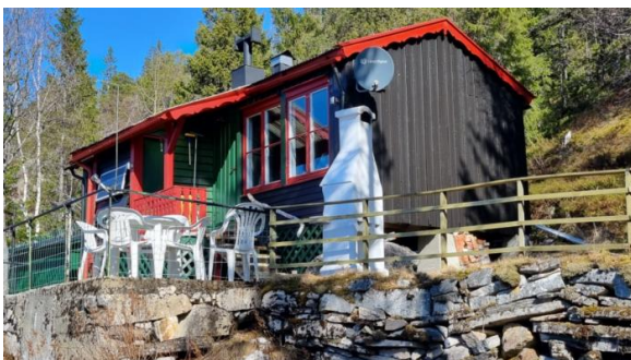
Forstøtningsmur av naturstein.
