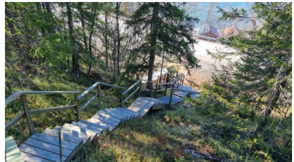
Trapp i terreng som adkomst til fritidsboligen.
