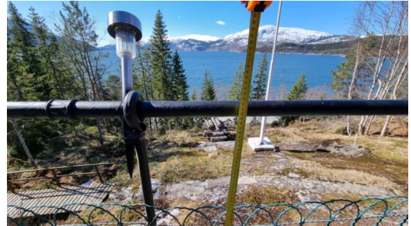
Kontroll av rekkverkshøyde på steinplatt.
