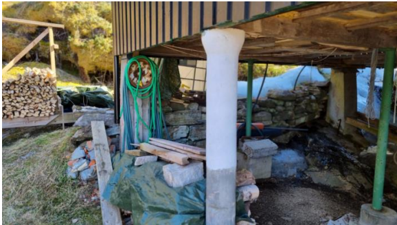
Kontroll av fundamenter.
