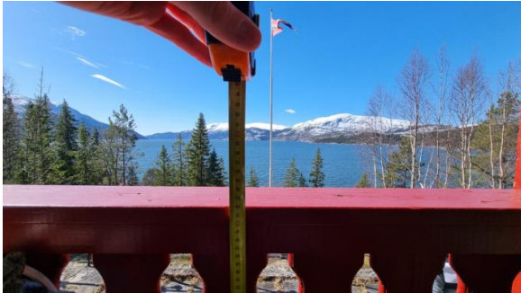
Kontroll av rekkverkshøyde på terrasse.
