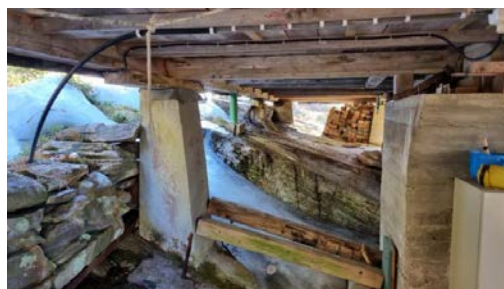
Kontroll av fundamenter.
