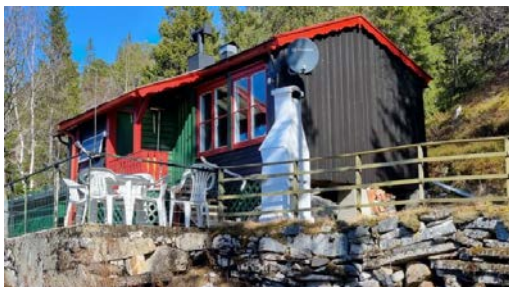
Forstøtningsmur av naturstein.
