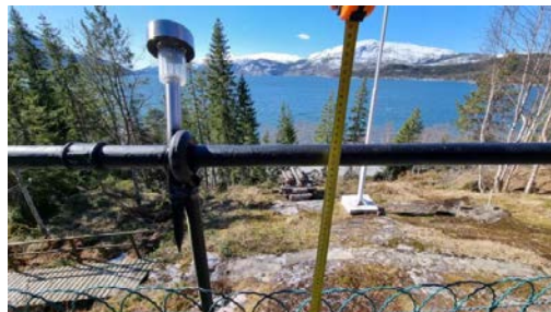
Kontroll av rekkverkshøyde på steinplatt.
