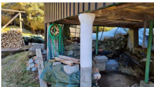
Kontroll av fundamenter.
