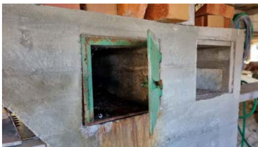
Kontroll av sotluke.
