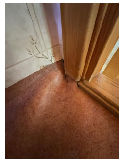
Gulvbelegg løsnet fra underlaget.
