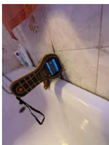
Ved fuktmåling ble det registrert tørre verdier.
