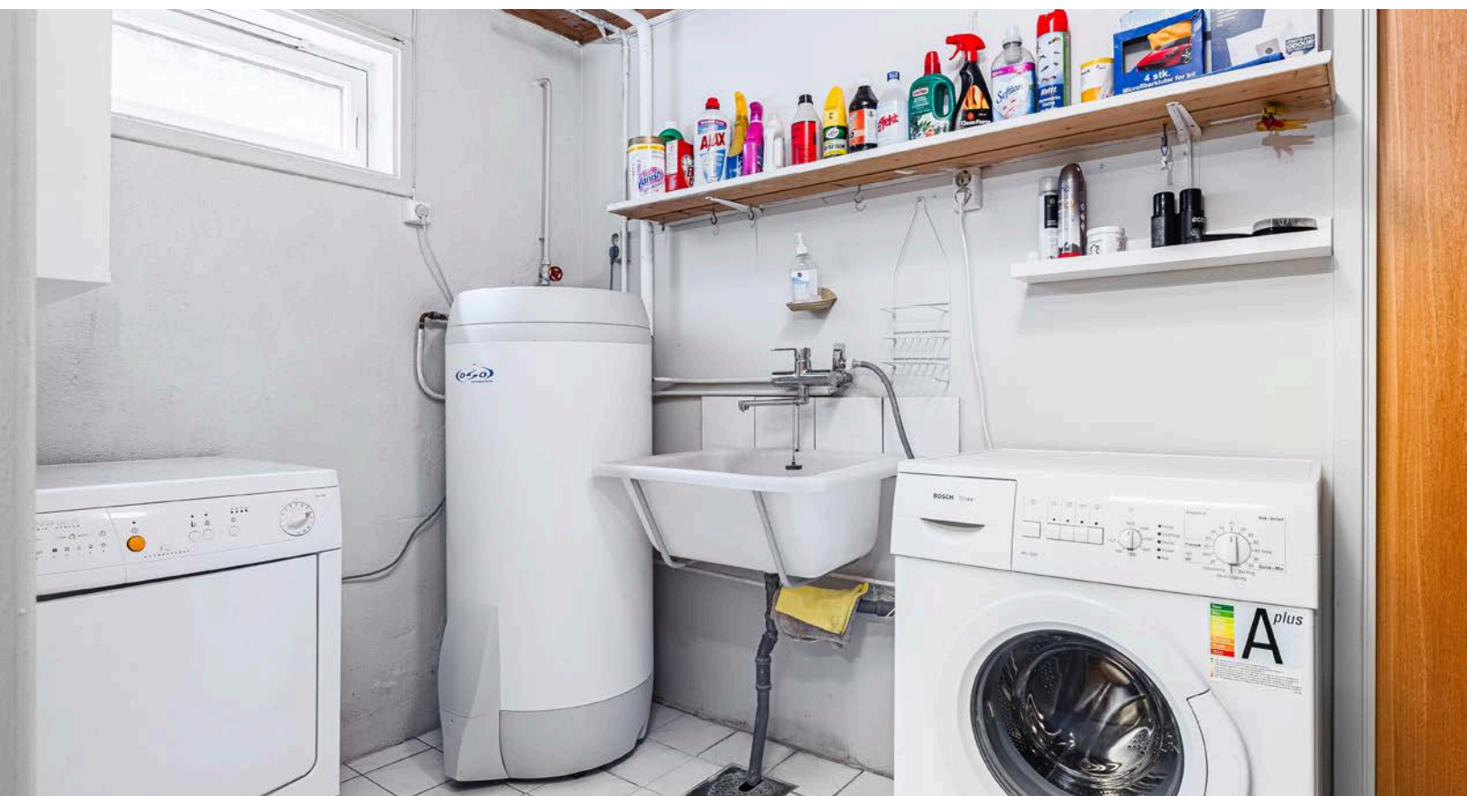
I underetasjen er det også et praktisk vaskerom med flislagt gulv. Vaskerommet er utstyrt med utslagskum, varmtvannsbereder og opplegg for vaskemaskin.
