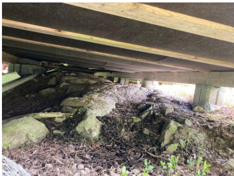
Fundament av blokker.
