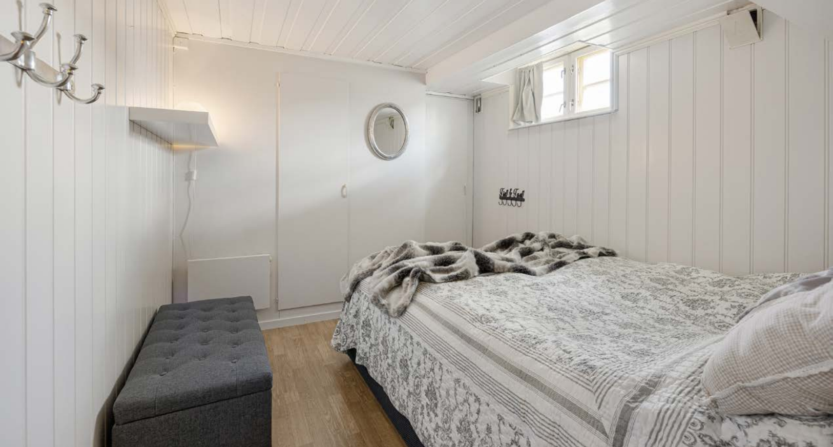
Rom i underetasjen som nåværende eier har brukt som gjesterom. Rommet er ikke bruksendret hos kommunen etter innredning, det er ikke godkjent til varig opphold og oppfyller ikke kravene til rømming og lyskrav.
