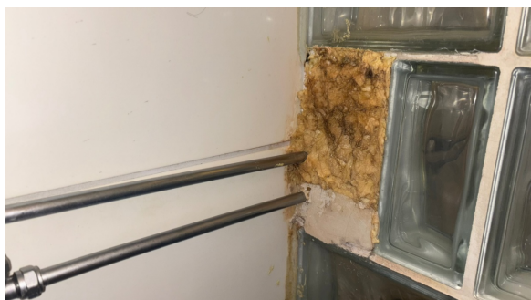
Glassbyggerstein er fjernet for rørføringer, og området er tettet med byggskum
