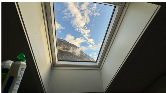
Takvindu på kjøkkenet og soverommet
