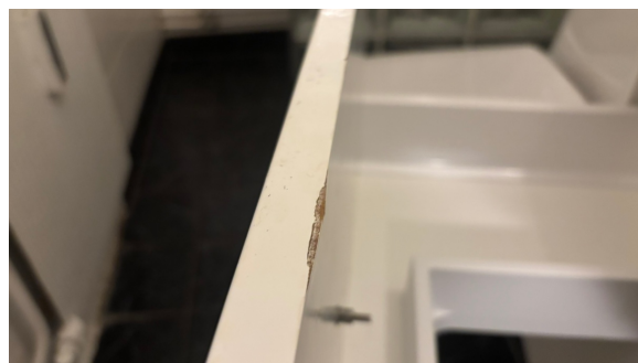
Liten skade på skuffeseksjonen
