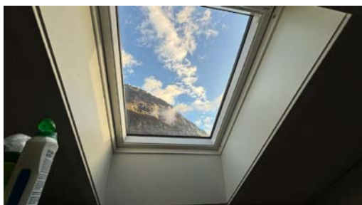
Takvindu på kjøkkenet og soverommet
