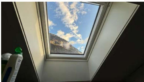
Takvindu på kjøkkenet og soverommet
