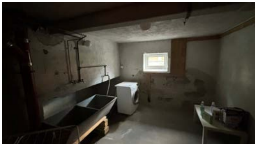
Vaskerom i kjelleren
