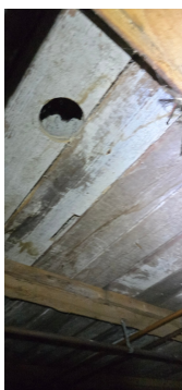
Synlig skeivheter under siden bjelkelag og bære søyle.
