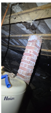
Synlig skeivheter under siden bjelkelag og bære søyle.
