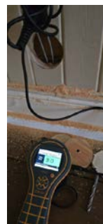
Hulltaking måling inn mot tømmer vegg.
