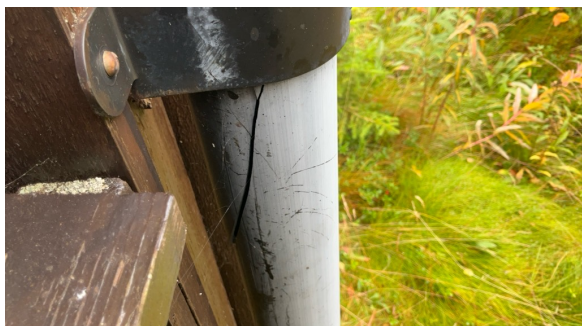
Frostsprengt takrennenedløp.
