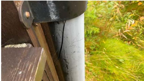
Frostsprengt takrennenedløp.
