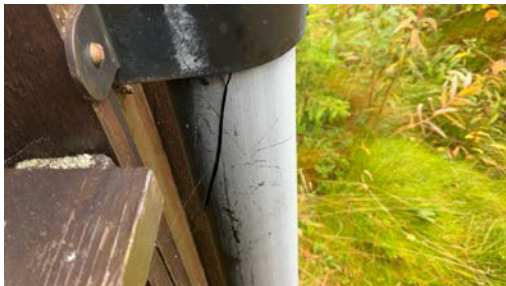
Frostsprengt takrennenedløp.
