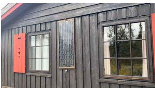
Solcelle på yttervegg.
