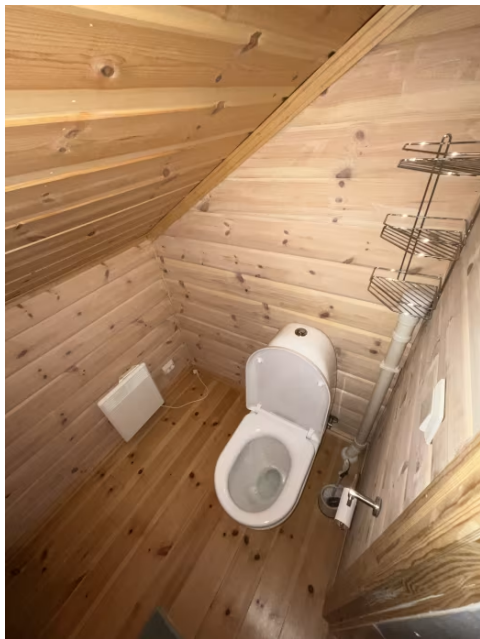
Viser panelovn, gulvstående toalett og lufting med vakumventil.
