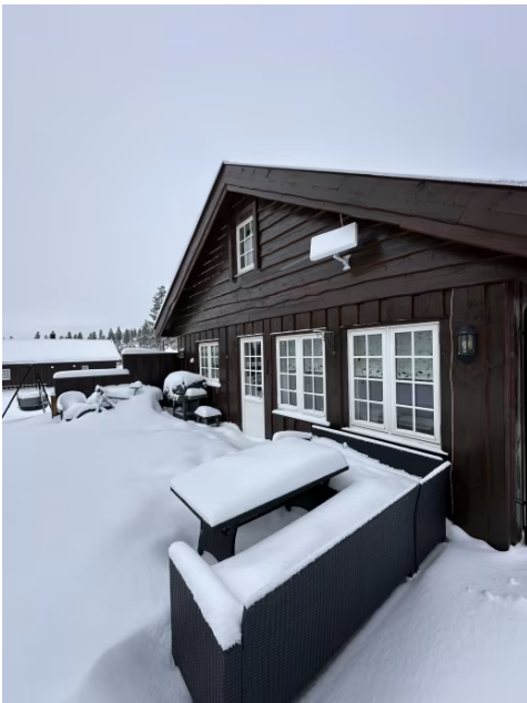
Balkong/terrasse er snødekt og ikke kontrollert.
