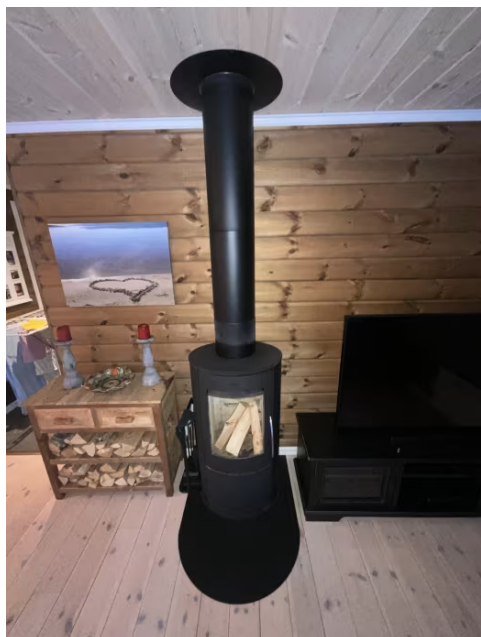
Viser ildsted montert i stue.
