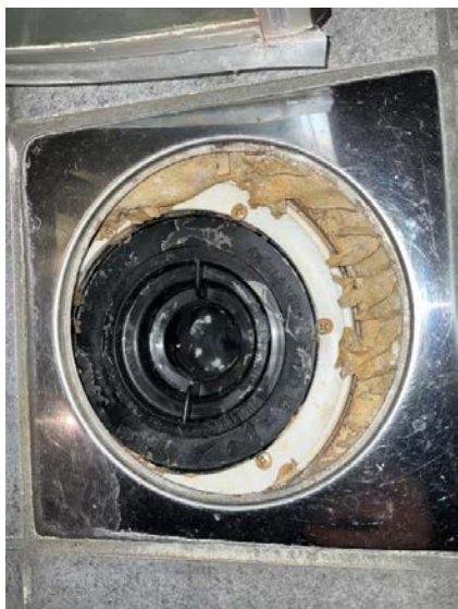
Viser sluk i dusjsone.
