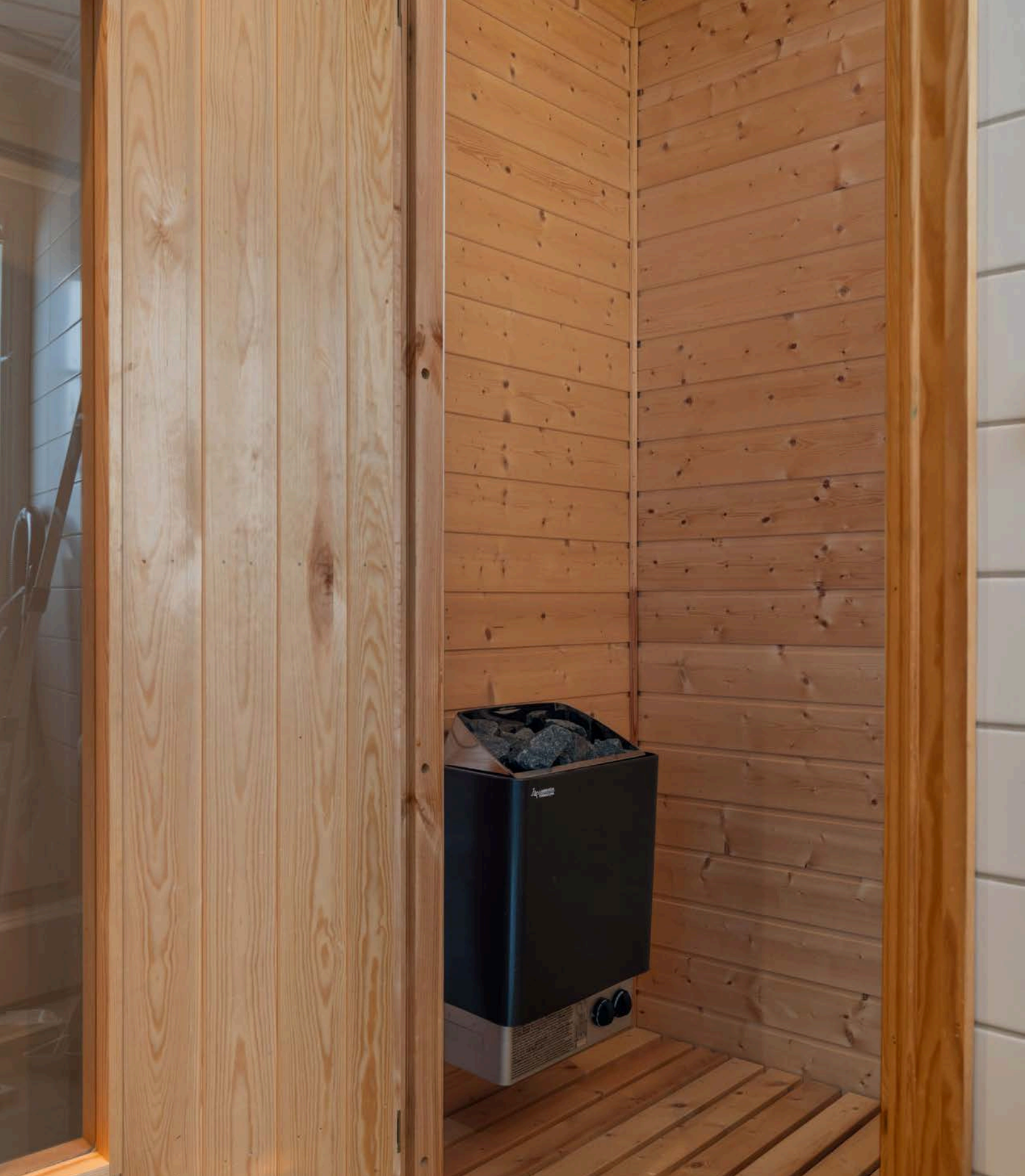
Badstuen har betonggulv dekket med trespiler, overflater med trepanel, plassbygde sittebenker av treverk og badstueovn av type Lagerholm.
