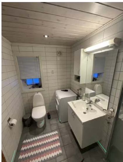
Det er etablert baderomsinnredning, heldekkende servantplate med 1-greps blandebatteri. Gulvstående toalett og opplegg for vaskemaskin.
