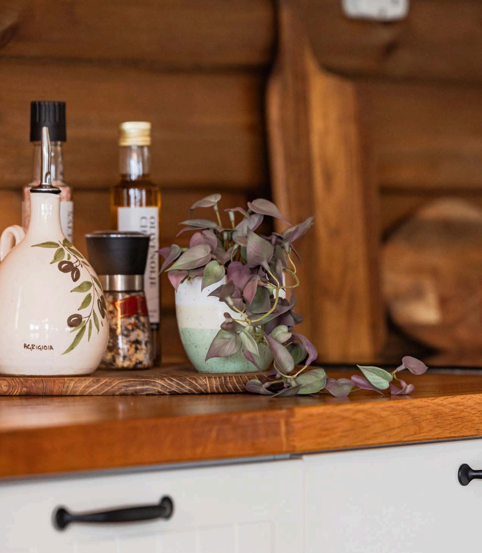
Det er montert komfyrvakt ved platetoppen og vannstoppeventil i benkeskap.
