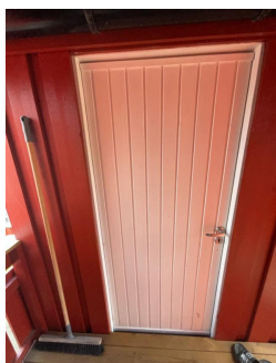
Verandadør har noe overflateslitasje og utvendig vrider virker ikke.
