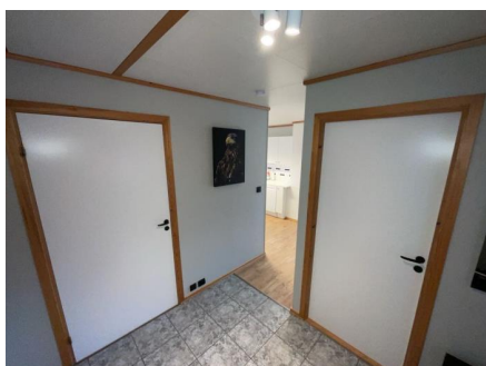
Dører sett fra gang mot soverom 1 og soverom 2. Dør til soverom 1 tar i bunnkarm
