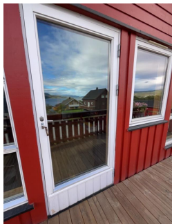
Verandadør har noe overflateslitasje og utvendig vrider virker ikke.
