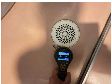
Fuktsøk er utført på gulv ved sluk uten forhøyde fuktverdier.
