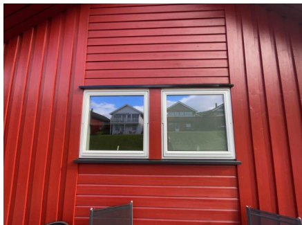
Vindu på soverom og bad
