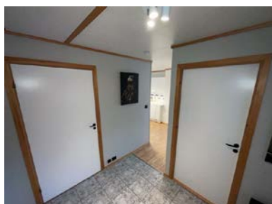
Dører sett fra gang mot soverom 1 og soverom 2. Dør til soverom 1 tar i bunnkarm
