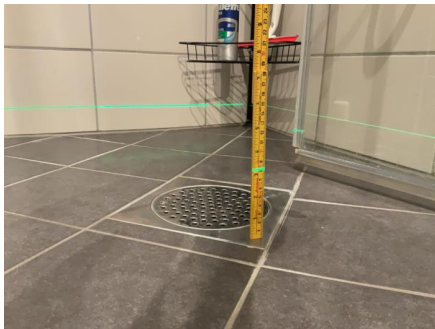
Målt fall til sluk: 31mm.
