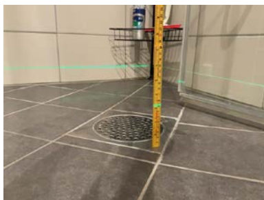
Målt fall til sluk: 31mm.
