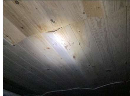
Kuving på trepanel i himling.
