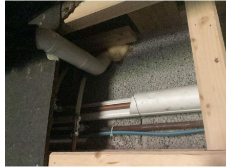
Innkassing av vannrør under ad er åpen.
