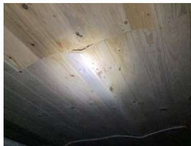
Kuving på trepanel i himling.
