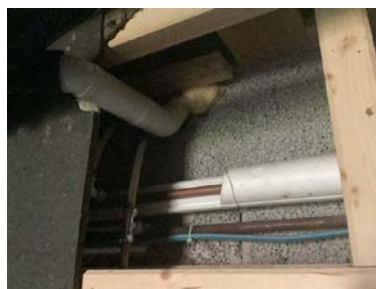
Innkassing av vannrør under ad er åpen.
