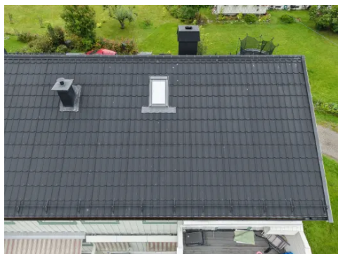
Boligen er tekket med metallplater.
