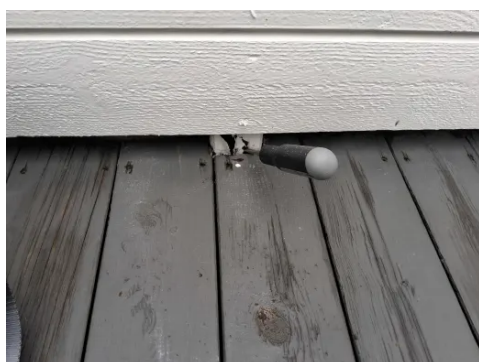
Råteskadet rekkverkstolpe.
