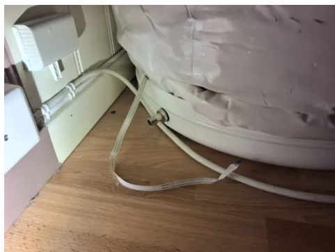
Sensorkabel er ikke koblet til.
