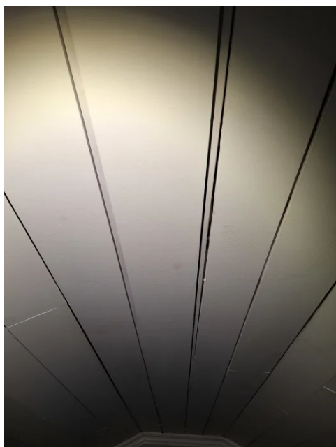
Gliper i panelbord i himling på loftsetasje.
