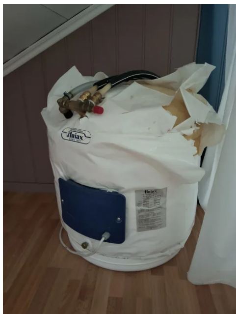
Varmtvannsbereder er koblet med plastrør.
