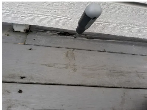
Råteskadet gulvbord.
