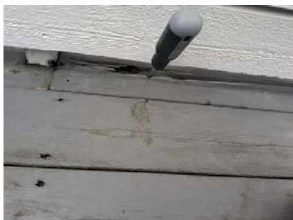
Råteskadet gulvbord.
