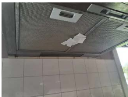
Avtrekkseffekt er testet med papir.
