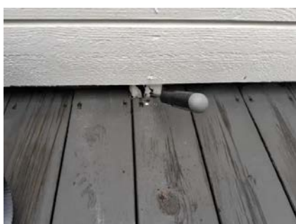
Råteskadet rekkverkstolpe.
