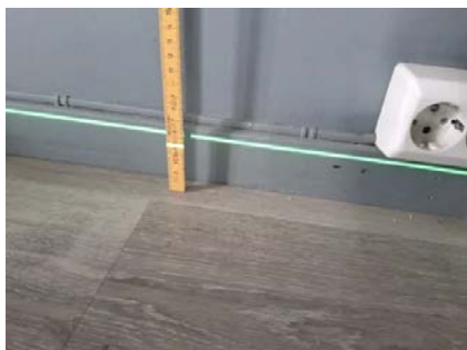
Etasjeskiller er kontrollert med nivelleringslaser.
