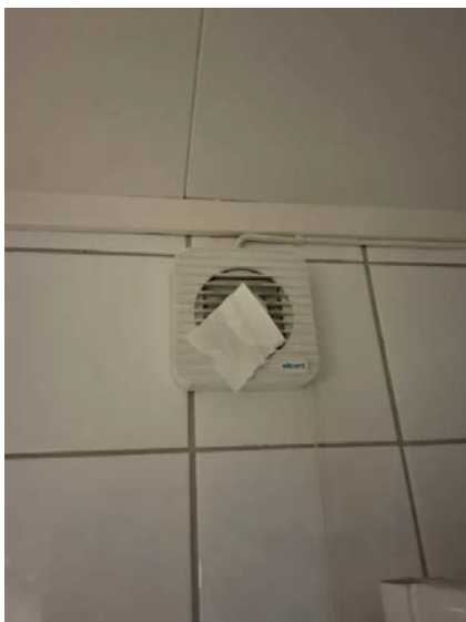
Avtrekkseffekt er testet med papir.
