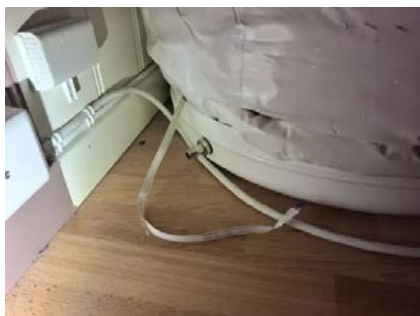
Sensorkabel er ikke koblet til.
