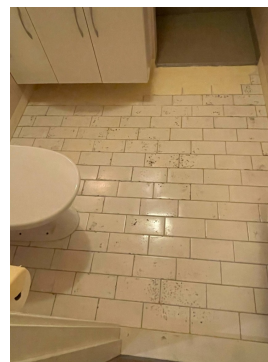
Fliser på gulvet under vinylfliser
