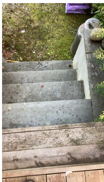
Trapp er for bratt og mangler rekkverk
