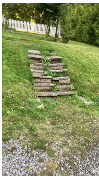
Trapp er for bratt og mangler rekkverk
