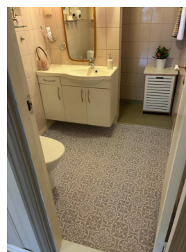
Fliser på gulvet under vinylfliser
