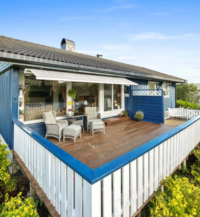
Det er levegg og trappetrinn mellom de to terrassenivåene på stuesiden.
