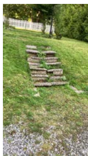
Trapp er for bratt og mangler rekkverk
