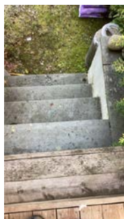
Trapp er for bratt og mangler rekkverk
