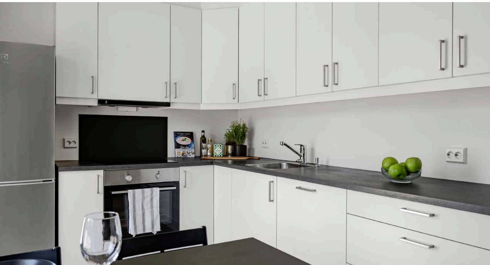
Kjøkkeninnredningen har hvite glatte fronter og laminert benkeplate med nedfelt oppvaskkum.
