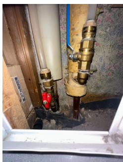
Samleskap med rørkurser og stoppekraner
