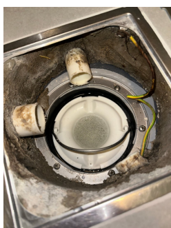
Plastsluk med klemring for membran
