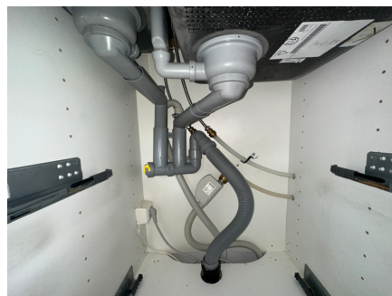
Rørøpplagg i kjøkkenbenk
