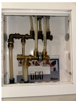
Samleskap med rørkurser og stoppekraner
