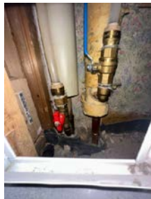
Samleskap med rørkurser og stoppekraner
