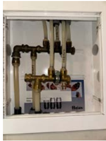
Samleskap med rørkurser og stoppekraner
