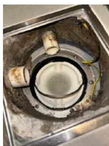
Plastsluk med klemring for membran
