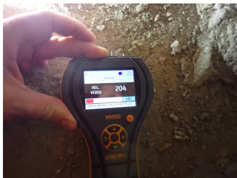
Fuktmåling på gulvoverflate.
