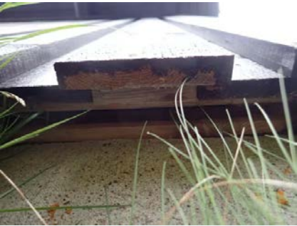
Oversikt oppunder kledning.
