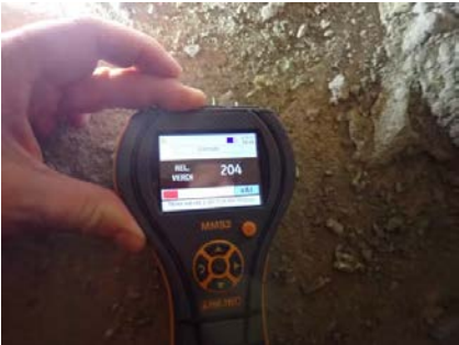
Fuktmåling på gulvoverflate.
