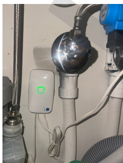
Røropplegg i kjøkkenbenk med Waterguard
