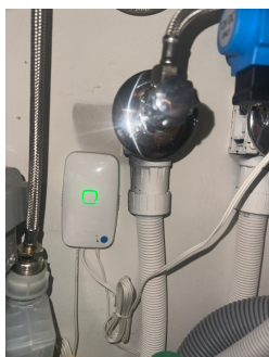
Røropplegg i kjøkkenbenk med Waterguard
