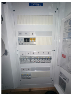
Sikringsskap med automatsikringer.
