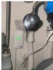
Rørøpplegg i kjøkkenbenk med Waterguard
