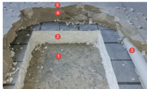
Foto 1. Avdekket gulvkonstruksjon på Røakollen. 1) er betongdekket hvor det eventuelt forekommer muggsopp. 2) trinnlydsplate i ca. 4 cm EPS, 3) vannbåren gulvvarme, 4) ca. 50 mm avretting på gulvet, 5) her ligger parkettunderlag og parkett.
