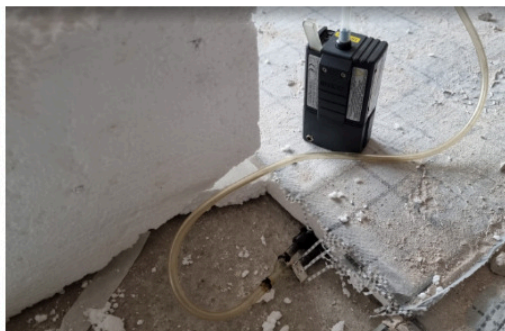
Foto 4. Prøvetaking mVOC under EPS ved åpning av konstruksjonen.
